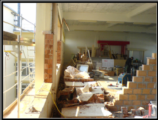
Pendant les travaux (~mars 2006)
